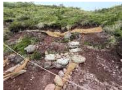
登山道、崩壊斜面に流土留め
