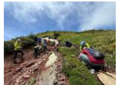
ロープ設置と挿し木作業
