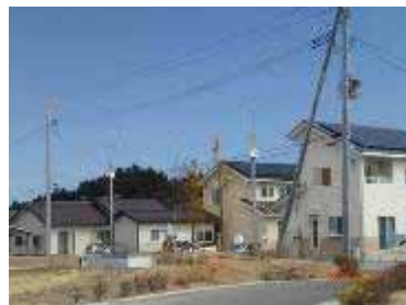
移転後、新築住宅が並ぶ
