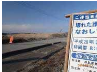
沿岸部の工事（新地町）
