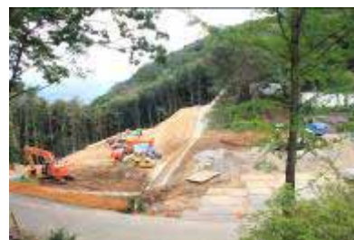
仮置き場の造成工事（信夫山）
